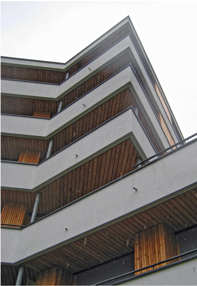
Blick auf die Westfassade
